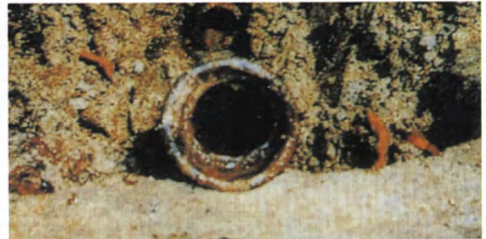
昭和27年に暗渠工事をした土管。目詰まりはしていない。
